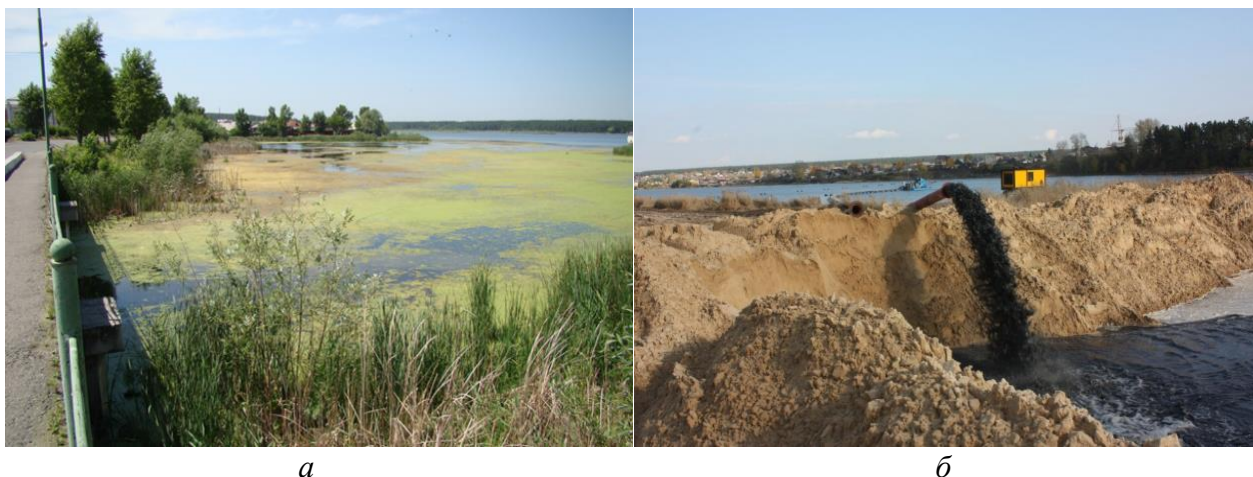
Рис. 1.5. Заиление водохранилища на реке Касмала Алтайского края (2014 г.) и его расчистка
