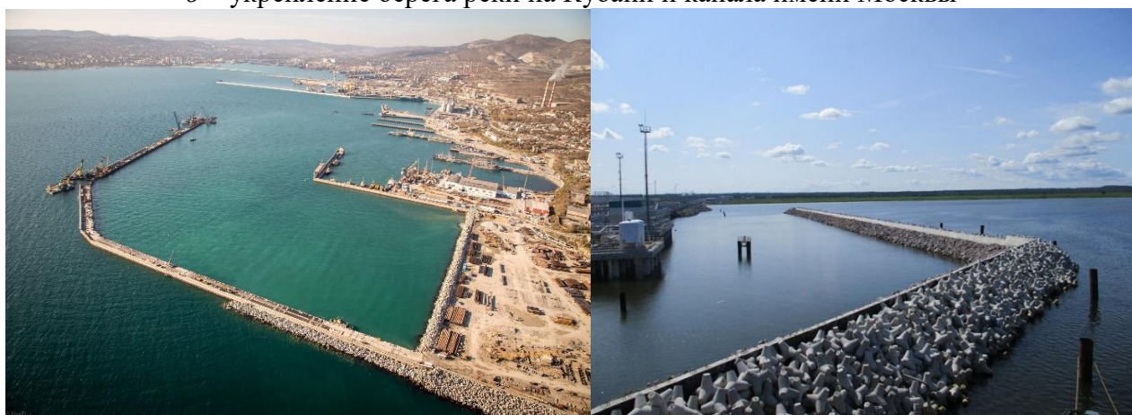
е – защитный мол в Новороссийске и защитное сооружение в Усть-Луге
