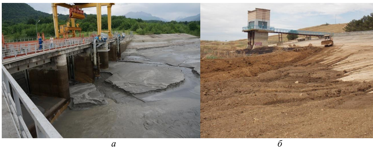
Рис. 1.6. Промыв от наносов гидроузла Кашхатау ГЭС на р. Черек (а) и очистка водохранилища Фронтное в Крыму от наносов и ила (б)
