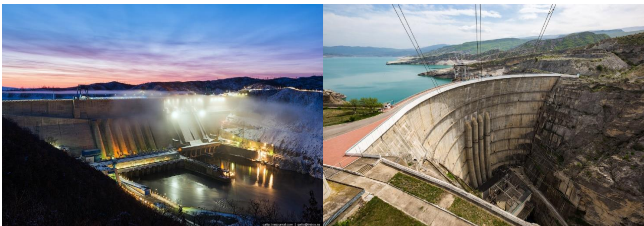
a – плотина Богучанской и Чиркейской ГЭС
